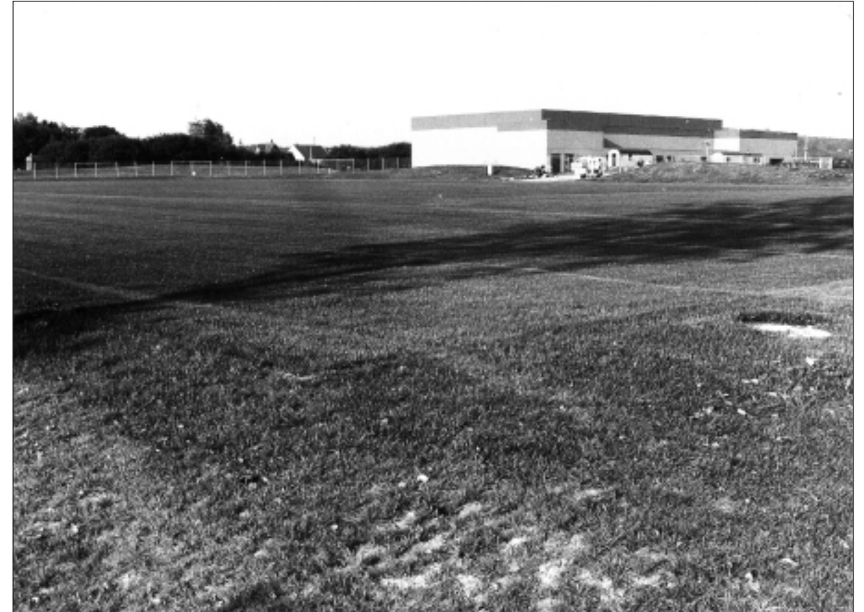
Sporthalle Schalkwiese im Bau 1979
