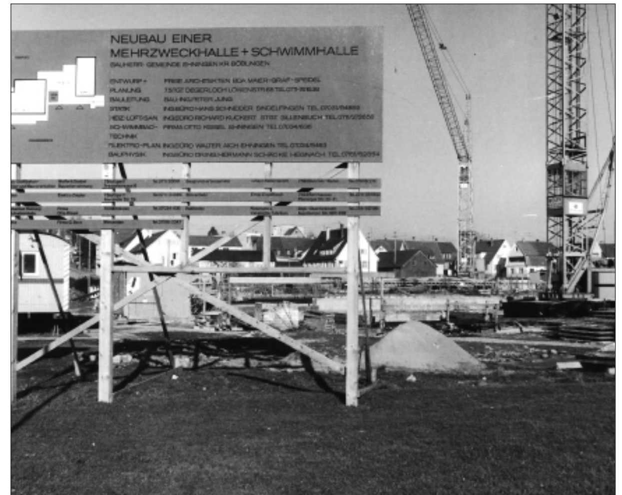
Die Mehrzweck- und Schwimmhalle im Bau
